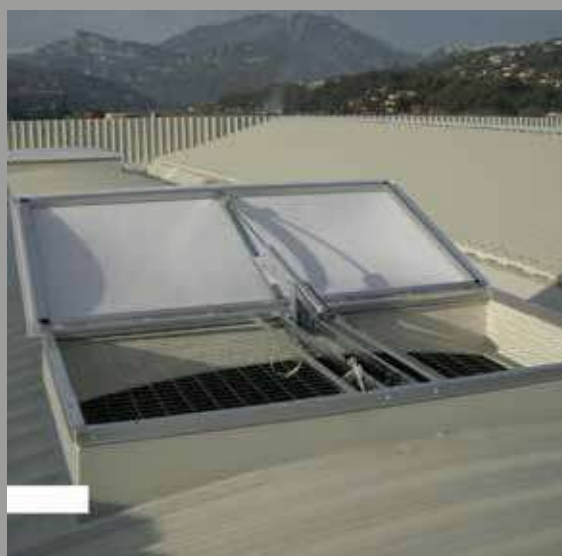
valvola doppio effetto con attuttore elettromagnetico
